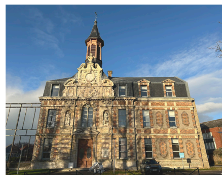
Fin décembre, l'échaffaudage de l'ancien hospice Louis Duflos a été retiré pour dévoiler un clocheton tout beau tout neuf !
